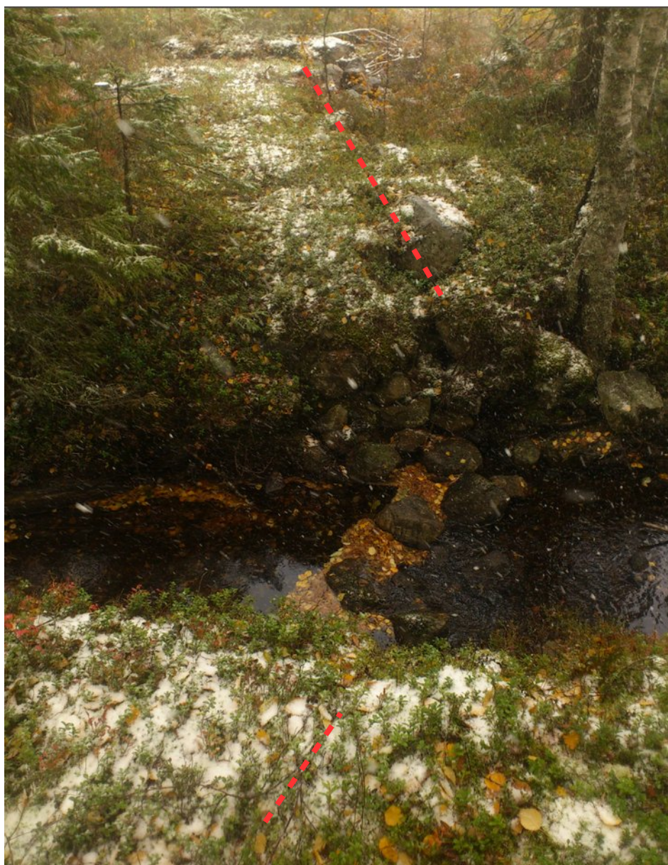
Dammrest nedströms Noret i Tryssjöbäcken. Röda streckade linjer markerar dammvallen.
